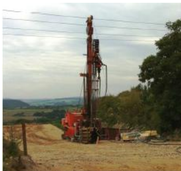
Bohrung in der Grube Rümmelsheim II
