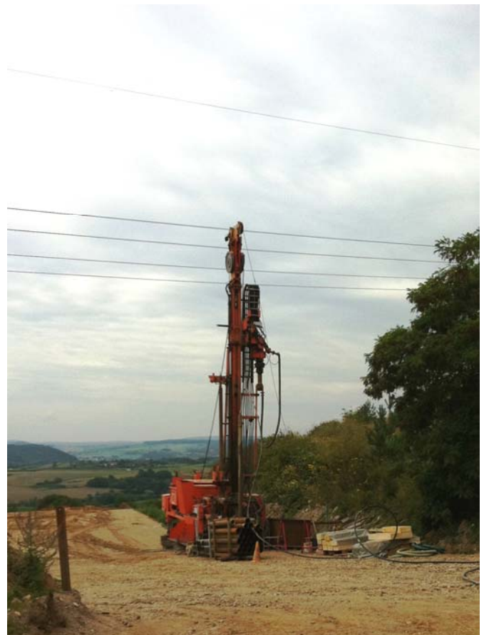
Bohrung in der Grube Rümmelsheim II
