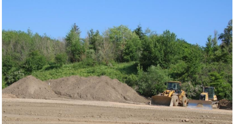
Fremdmassen auf dem Sammelplatz warten auf das Laborergebnis. Vorher dürfen diese nicht verfüllt werden. Foto: H. Grimm
